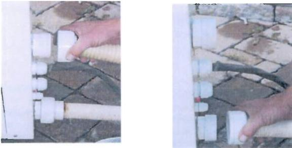
2. Boucher l'orifice du bas avec un bouchon puis, rincer l'intérieur de l'échangeur en insérant un boyau d'arrosage dans l'orifice du haut. Laisser l'eau s'écouler 30 à 45 secondes.
