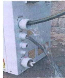
3. Enlever le bouchon du bas et aspirez l'eau restante dans l'échangeur à l'aide d'un aspirateur (Shop Vac) en insérant le boyau dans l'orifice du bas tout en bloquant en partie l'orifice du haut avec votre main.
